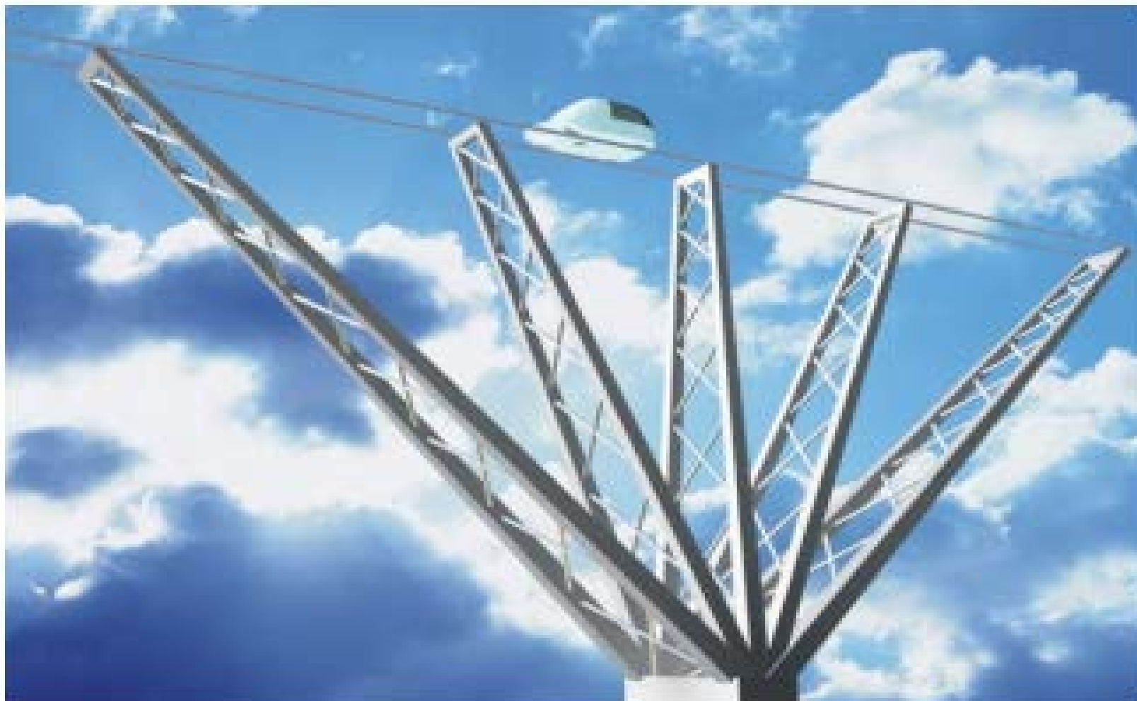
Рис. 24. Высокая поддерживающая опора, совмещённая с вертикальной кривой большого радиуса (вариант)
